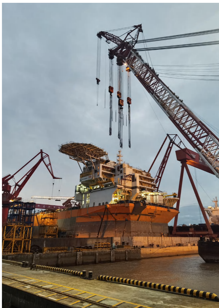
FPSO 上建总段异地完整性建造
